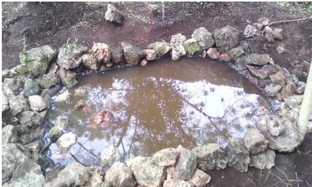
Figura 15 Piedras colocadas sobre el impermeable
