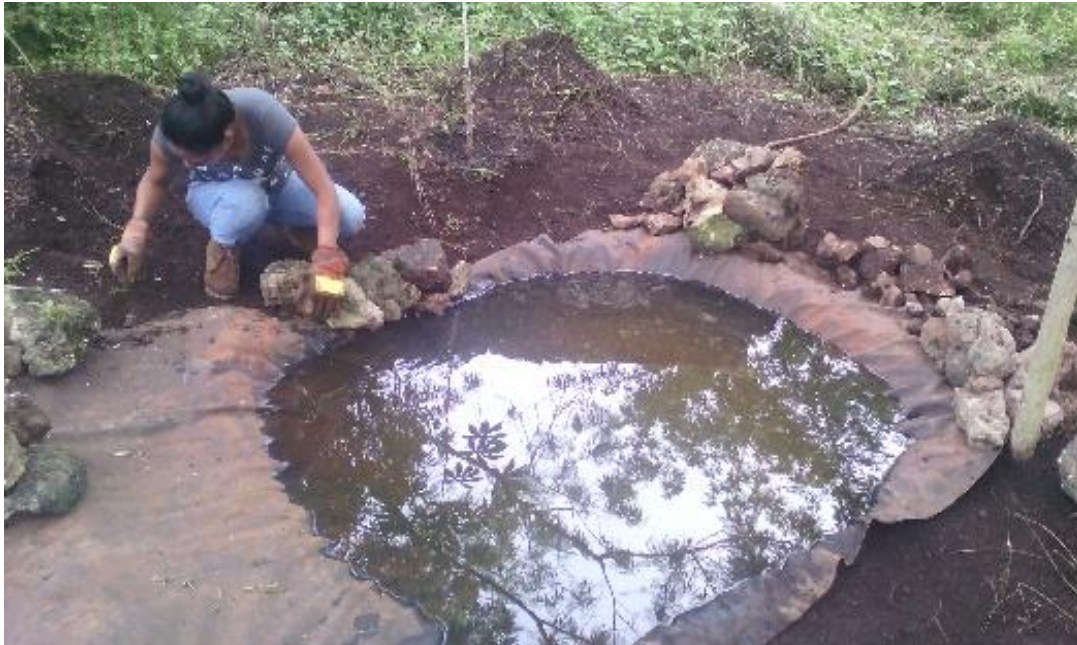
Figura 14 Colocación de las piedras alrededor del impermeable
